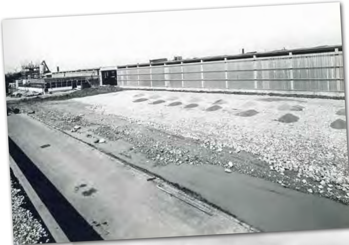
Byggeriet af centrallageret på Rørvang, juni 1965.
